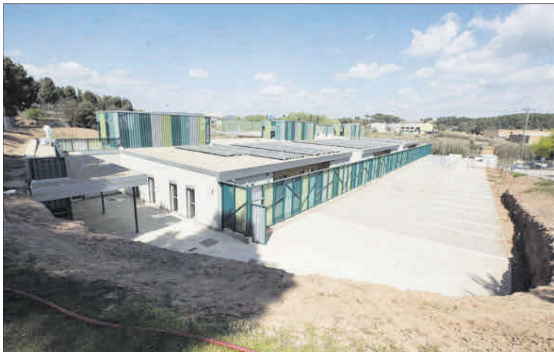
Una imatge de l'edifici, ahir, amb les obres a l'exterior acabades
